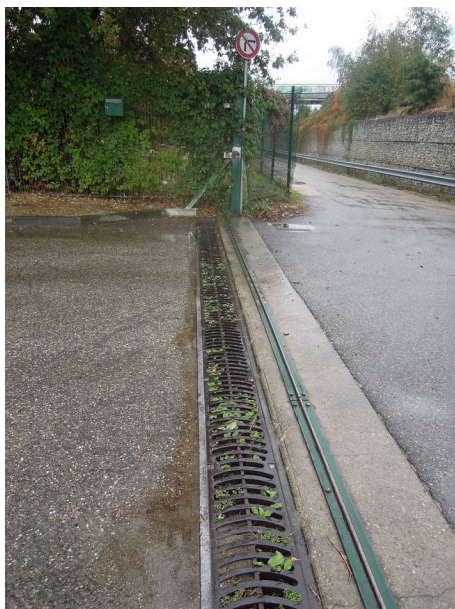
Caniveau de collecte des eaux susceptibles pluviales susceptibles d'être polluées.
