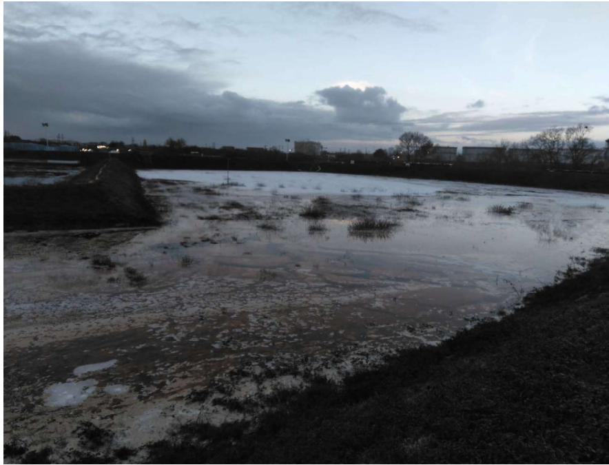
Tapis de mousse absent sur certaines zones de la sous-cuvette 70A
