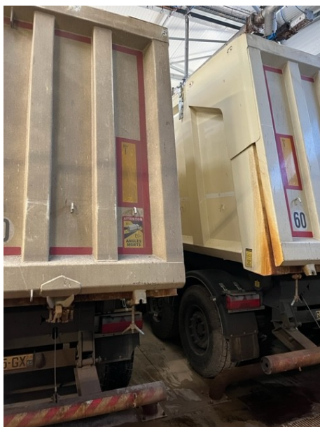
Bennes de stockage des boues issues du prétraitement
