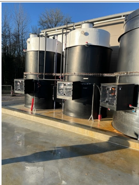
Stockage acide et chlorure ferrique
