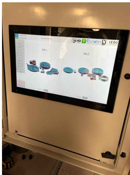
Nouvel automate de pilotage
