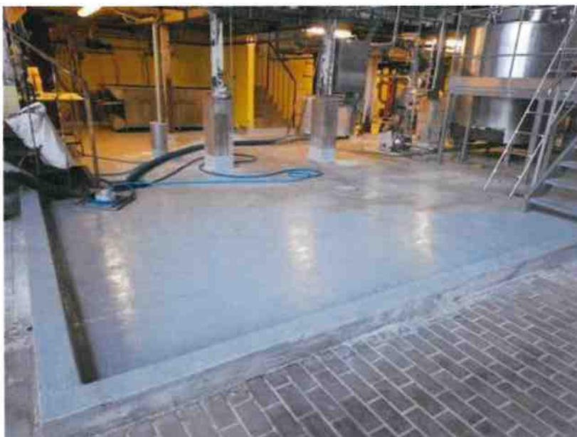
"rétention sous l'évaporateur"
