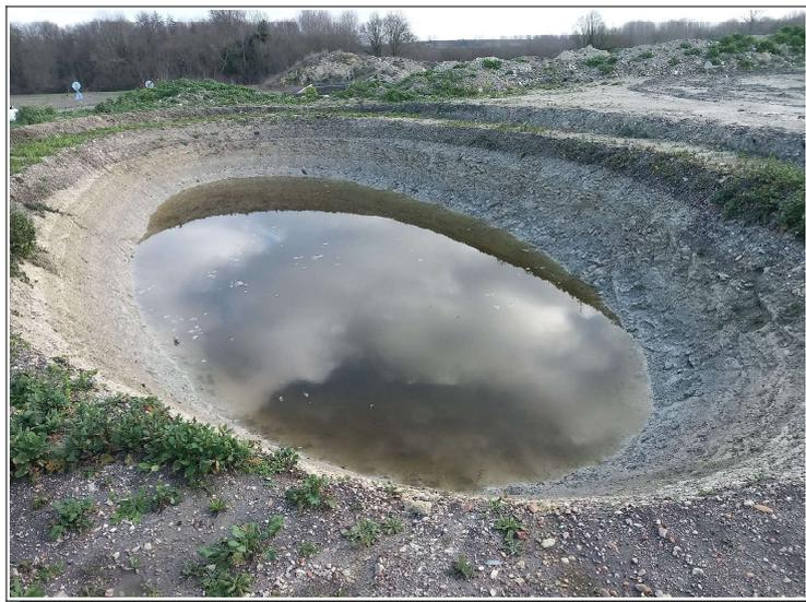
Par ailleurs, le design du bassin a été modifié par rapport à la description (forme rectangulaire) figurant dans le dossier : une forme elliptique a été retenue pour la construction du bassin, dont les dimensions n'ont pu être présentées par l'exploitant.
