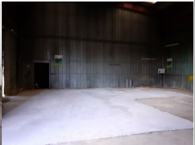
Ancienne fosse dans le bâtiment ayant fait l'objet d'un dépollution (voir ci-après)
