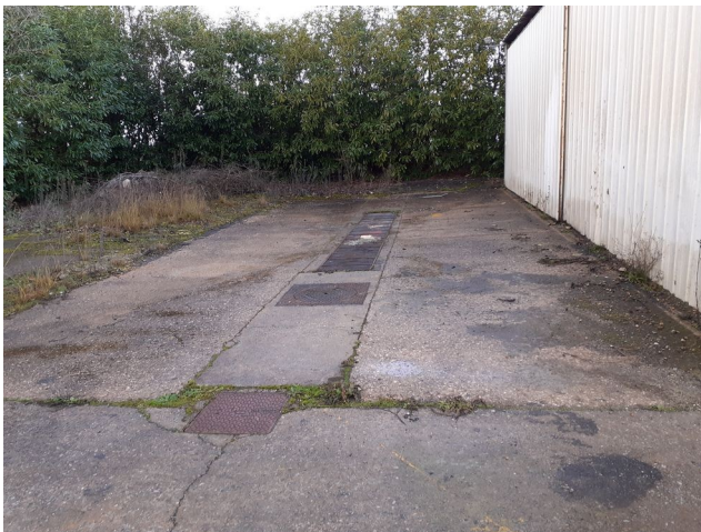
Ancienne aire de lavage
