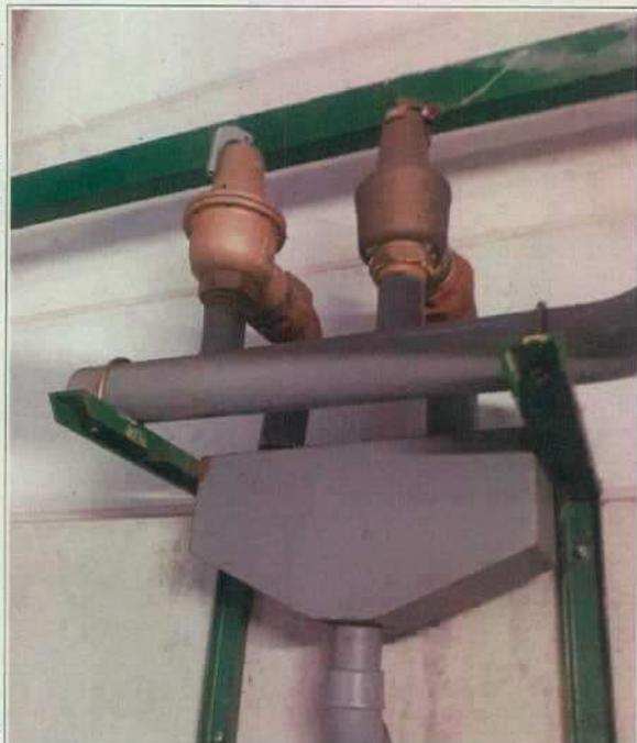
→ Non-conformité : L'exploitant n'a pas pu justifier la présence d'un dispositif de sécurité associé aux vases d'expansion des chaufferies gaz.
