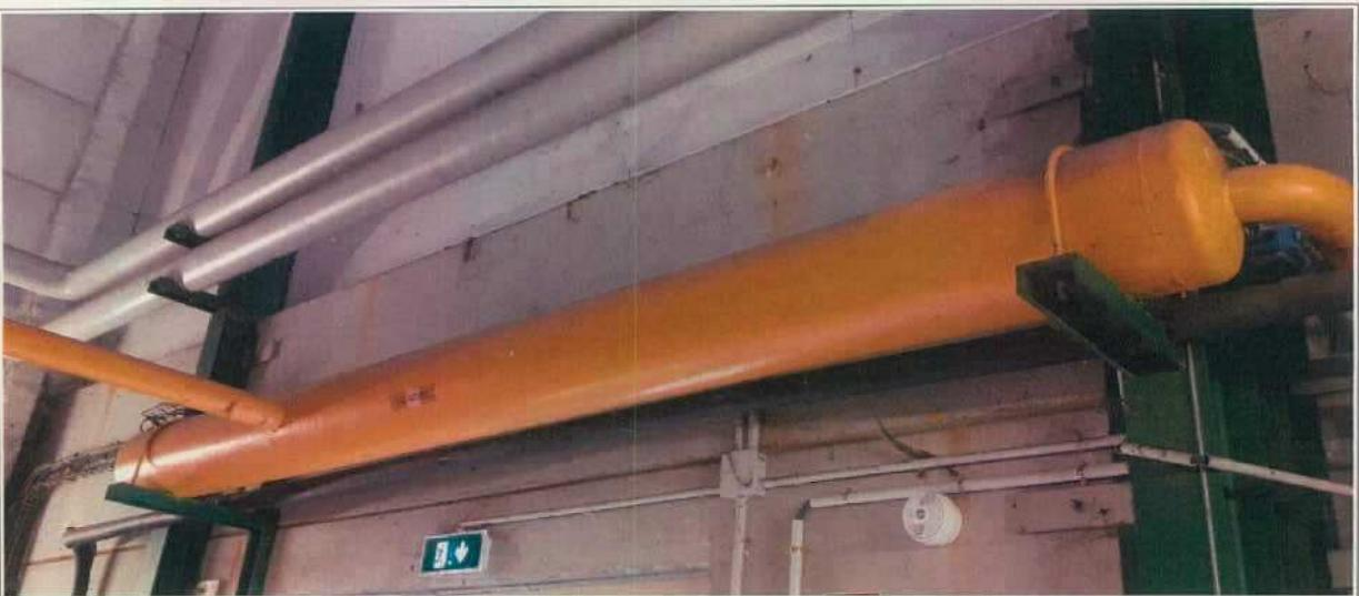
→ Non-conformité 5-2 : L'exploitant n'a pas pu justifier si la bouteille tampon gaz en chaufferie du bâtiment B est un équipement sous pression soumis à l'arrêté du 20/11/2017.
