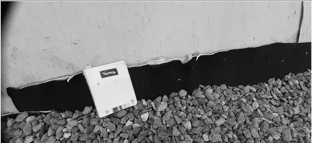
La couche drainante de substitution ainsi constituée du géocomposite de drainage (perméabilité de 100 litres/s/m<sup>2</sup>) et de 30 cm minimum de granulats 20/40 a une perméabilité qui, selon le tiers expert (avis technique du 25/01/22) est plus de 3 fois supérieure à celle correspondant à 50 cm de granulats 20/40. La perméabilité est donc nettement supérieure à 1.10<sup>-4</sup> m/s.
