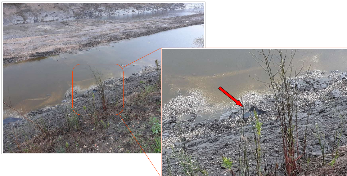
Lagune de stockage des sédiments avec un relevé de membrane visible
