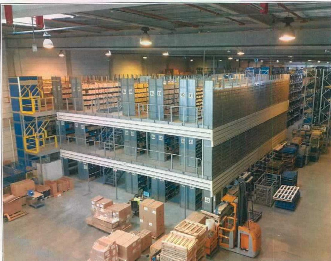
L'exploitant n'a pas pu démontrer que le déisenfumage de la cellule n'est pas entravé par les mezzanines.
