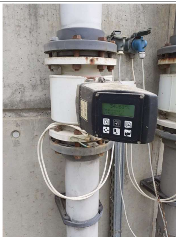
Débitmètre électromagnétique positionné sur la canalisation en charge
