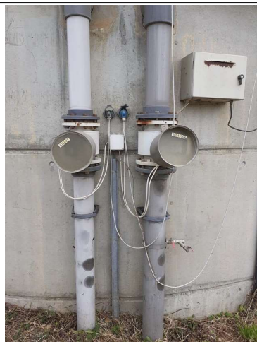
Canalisations en charge des sites Gillot (à gauche) et Bolaidor (à droite) et protection du débitmètre par un cache
