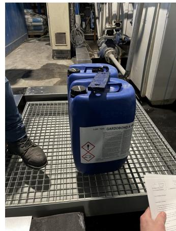
L'inspection a constaté également l'absence de dispositif d'alarme en point bas de la rétention. Or les dispositions de l'article 54 de l'arrêté du 9/04/19 relatif aux prescriptions générales applicables aux installations relevant du régime de l'enregistrement au titre de la rubrique n° 2565 précisent que les capacités de rétention de plus de 1 000 litres sont munies d'un déclencheur d'alarme en point bas. **Observation 4**
