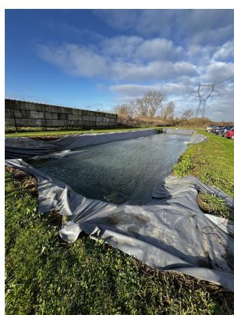
Par ailleurs, l'inspection a alerté l'exploitant sur l'absence d'ancre de la bâche du bassin pouvant induire une non-étanchéité du bassin. **Observation 7**
