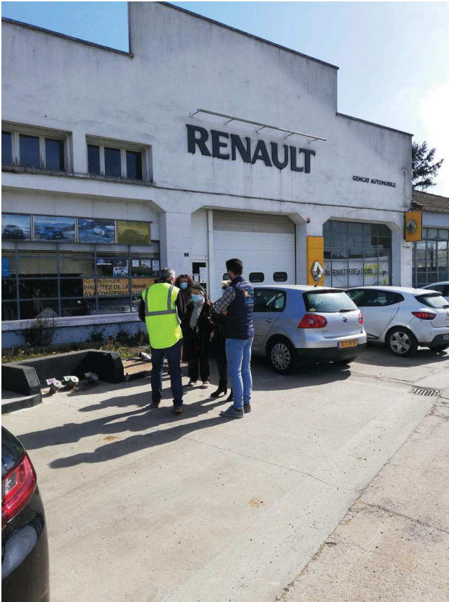
Vue avant des bâtiments
