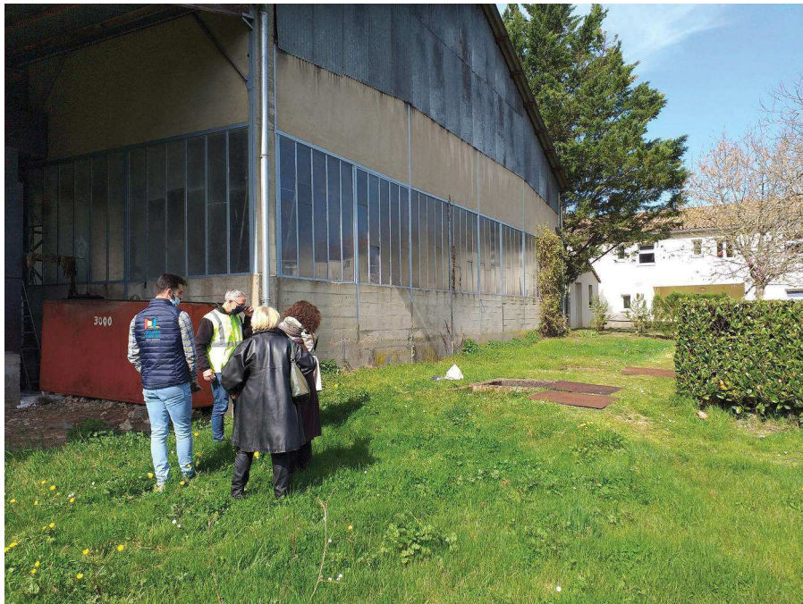
Vue de l'arrière des bâtiments avec les plaques métalliques qui protègent les cuves enterrées
