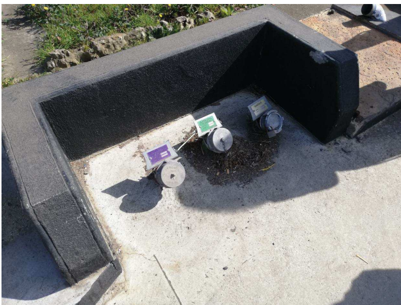
Détail des anciens orifices de canalisation permettant l'empotage des cuves.
