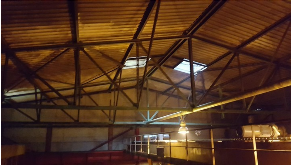
Toiture et trappe de désenfumage :
