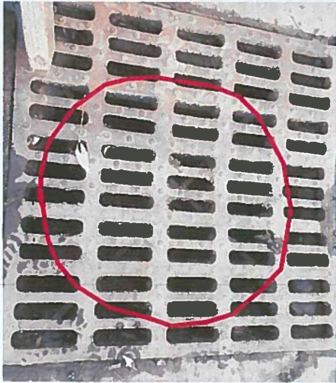
Grille de collecte avec panier de récupération (bord du panier illustré en rouge)
