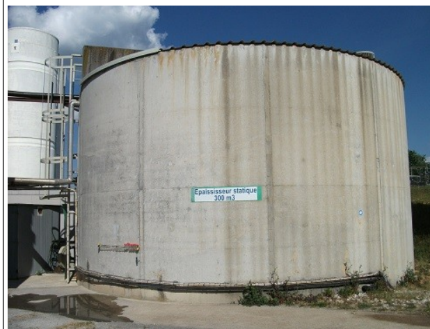
Stockage des boues provenant de la déphosphatation (300 m 3 max).
