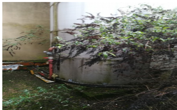
Présence d'une cuve aérienne dans une cour intérieure mitoyenne à l'ancien bâtiment de production contenant a priori des effluents non identifiés.
