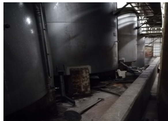
Présence d'autres cuves aériennes sur rétention sur site
