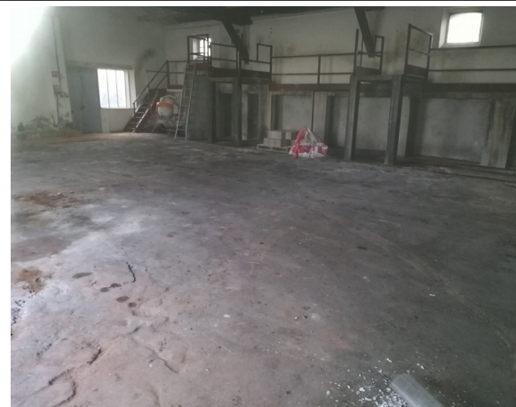
La dalle de l'atelier de conditionnement présentant un état de dégradation avancé
