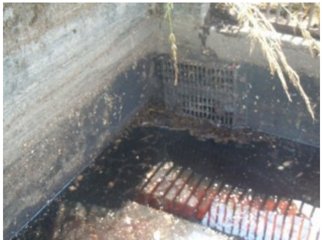
Grille du bassin de décantation avant envoi des eaux pluviales vers le bassin d'orage et de confinement
