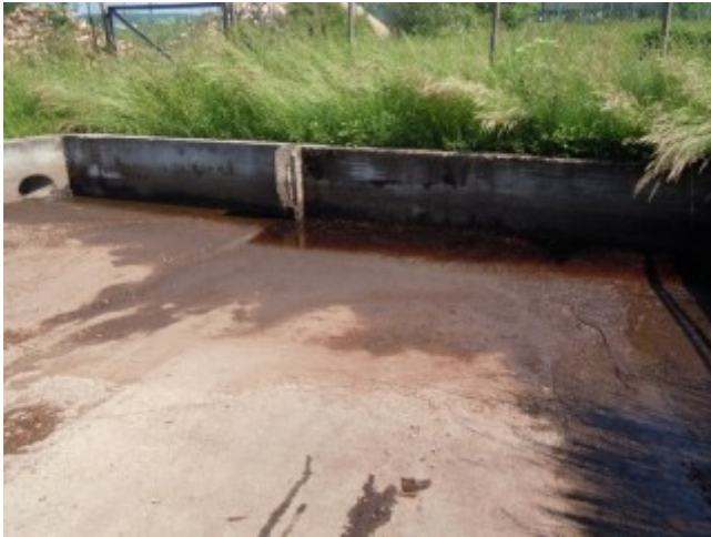
Bassin de décantation en amont du bassin d'orage et de confinement
