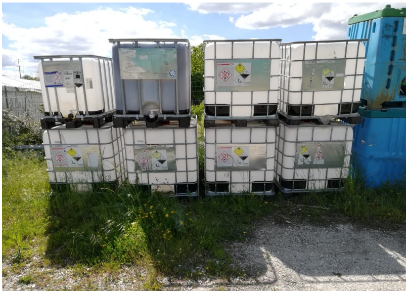
Stockage, à l'extérieur, de fûts de produits susceptibles de créer une pollution des eaux ou des sols sans aucune rétention
