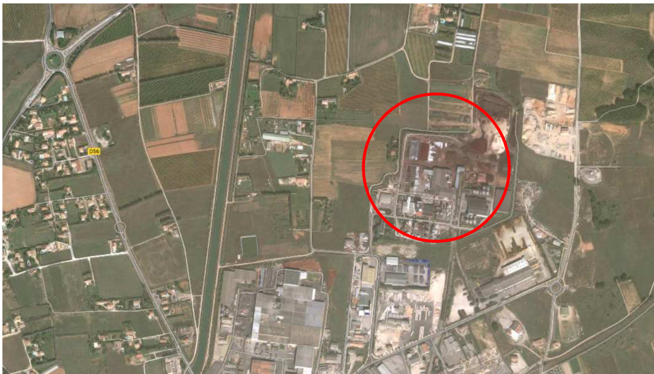
Fig.2 : Photographie aérienne (environnement du site)
