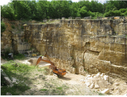
Photo 1 : Zone en cours d'extraction
