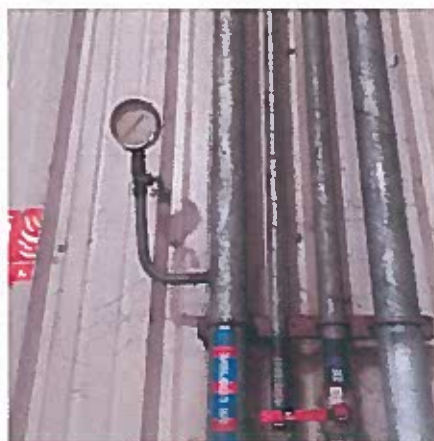
Jauge air comprimé bâtiment 12
