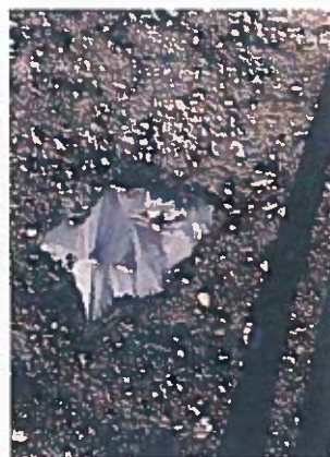
Secteur SC44 (géomembrane endommagée)
