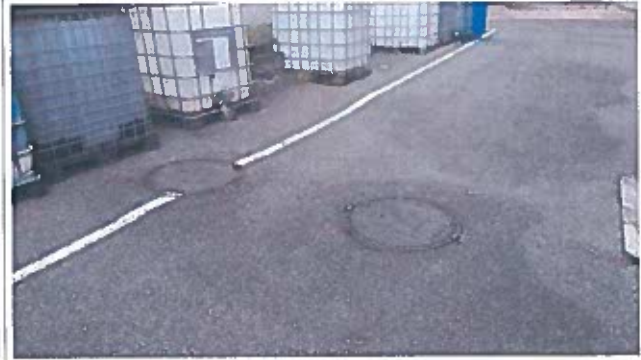
Photo 10 : trappe sur le déshuileur (eau pluviales et eaux usées)
