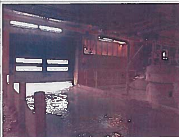
Débordement eaux process au niveau de la zone matières premières. Les balles de papiers obturent les regards eaux pluviales.
