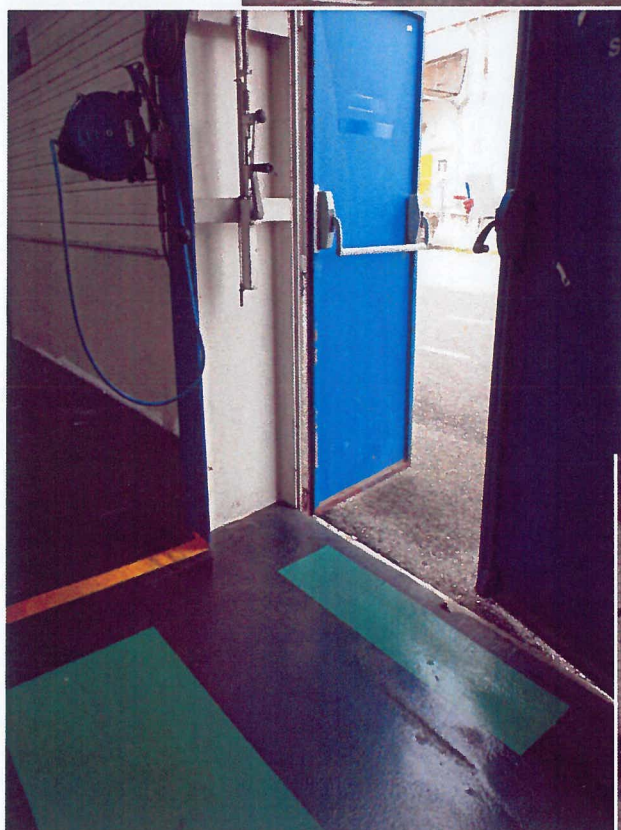
Vue n° 5 : Porte en facade Ouest de B30, absence de seuil ou de confinement pour retenir les eaux incendie.
