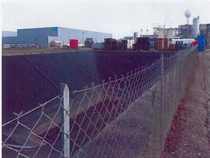
Vue n° 8 : Capacité de confinement eau incendie face au quai de B30
