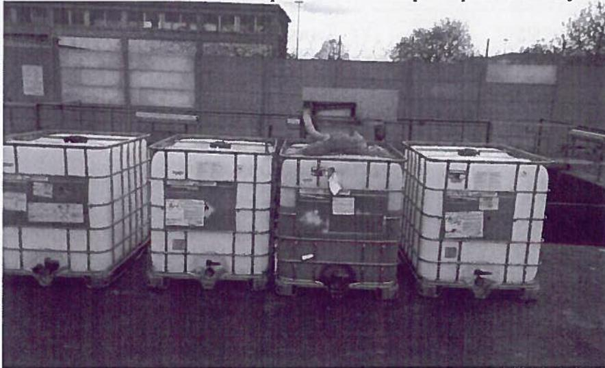
➤ **Demande n° 22 : l'exploitant doit corriger la situation et mettre des dispositifs de rétention pour ces cuves.**
