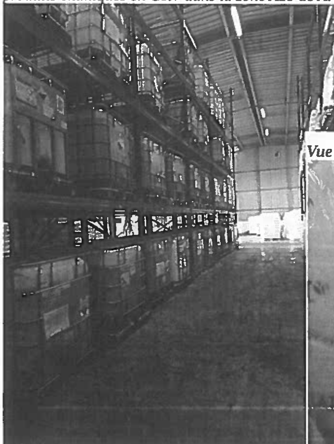
Vue n° 13 : Stockage à plus de 5 m de hauteur de produits chimiques en GRV dans la zone A1b de A.
