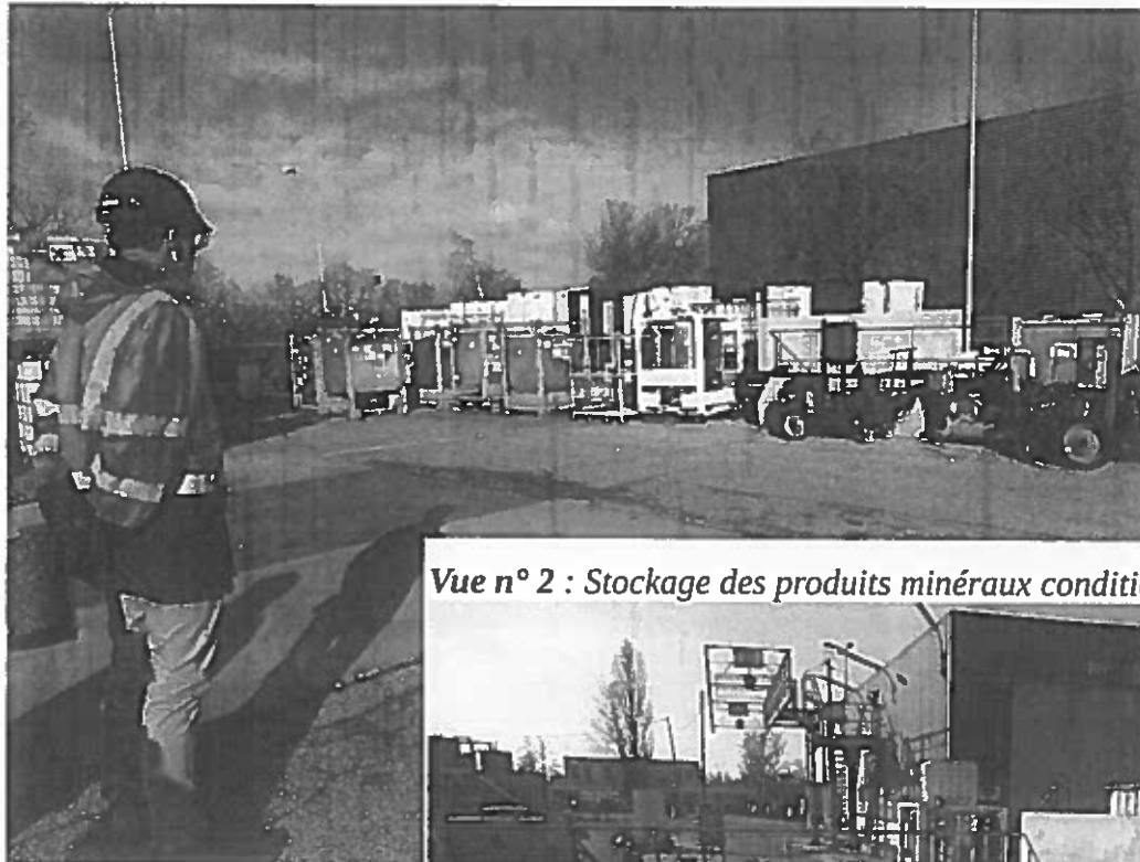
Vue n° 1 : Emplacement du bâtiment L détruit. Zone de stockage des produits minéraux conditionnés.
