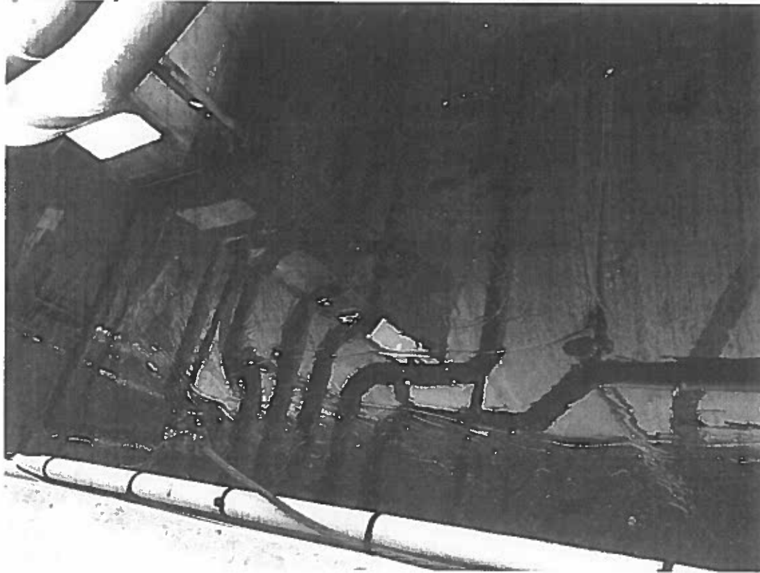
Vue n° 4 : Solvant pétrolier surnageant dans la capacité de rétention de S3. Partie Sud de la capacité.
