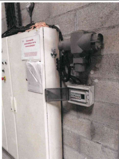
Photo 1 commande automatique de la vanne pompier
