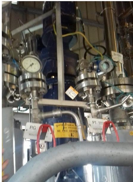
**Observation n°3:** l'exploitant vérifiera si les conditions de montage de ces piquages sont susceptibles d'impacter la sécurité de l'équipement notamment si cela a pu dégrader la soudure des piquages concernés. Il fera appel si besoin à l'expertise d'un organisme compétent en matière d'appareils à pression.
