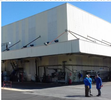
**Non conformité n°2 :** les conditions de rejet de la ventilation (à environ 6 m de haut en façade et à l'horizontale) ne correspondent pas aux conditions présentées dans le dossier de modification de 2016. Les distances d'effet affichées en annexes 2 et 3 sont donc susceptibles d'être revues à la hausse en ce qui
