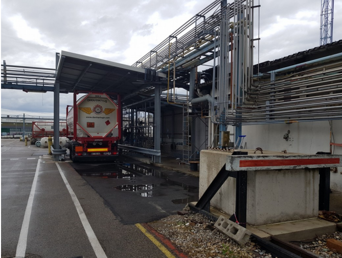
Poste de dépotage et heurtoir en béton
