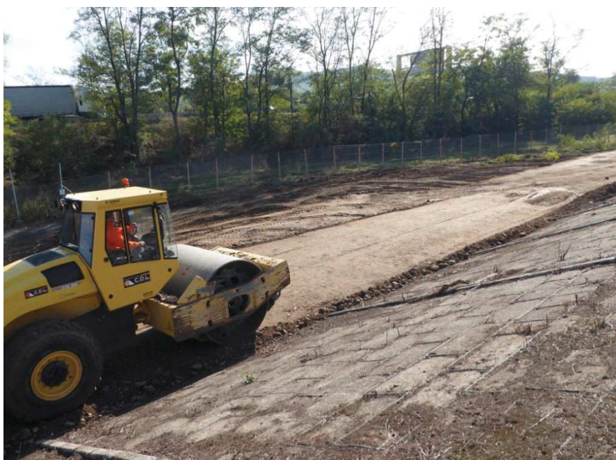
Compactage en pied de digue coté Allier
