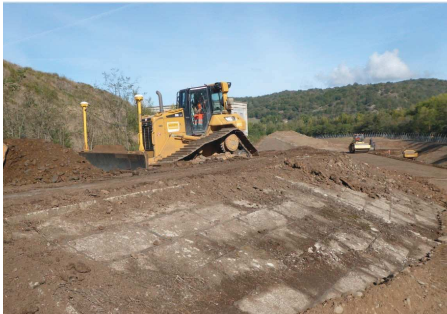
début de la réhausse par remblaiement coté sud
