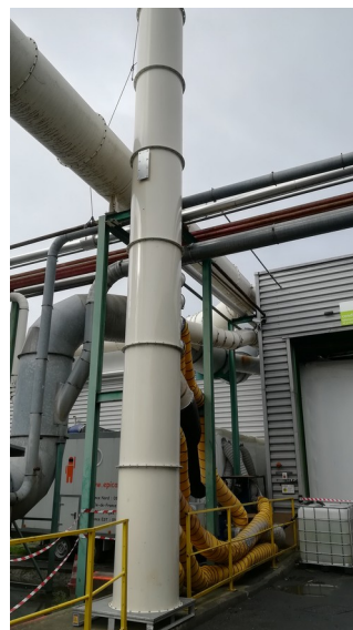
Vue de l'arrière de la structure de confinement avec en fond d'image le sas d'accès du personnel et en premier plan les conduites d'aération
