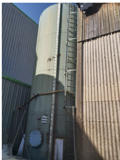
Photographie n°4 : vue rapprochée de l'abri où sont stockés les cuves dont le positionnement doit être revu et la rétention nettoyée.
