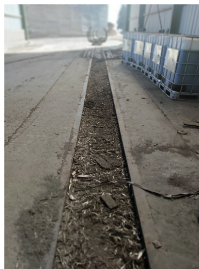
Photographie n°4 : vue rapprochée de l'abri où sont stockés les cuves dont le positionnement doit être revu et la rétention nettoyée.
