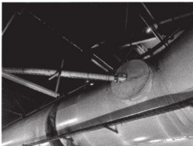
Nouveau point d'injection de chaux
