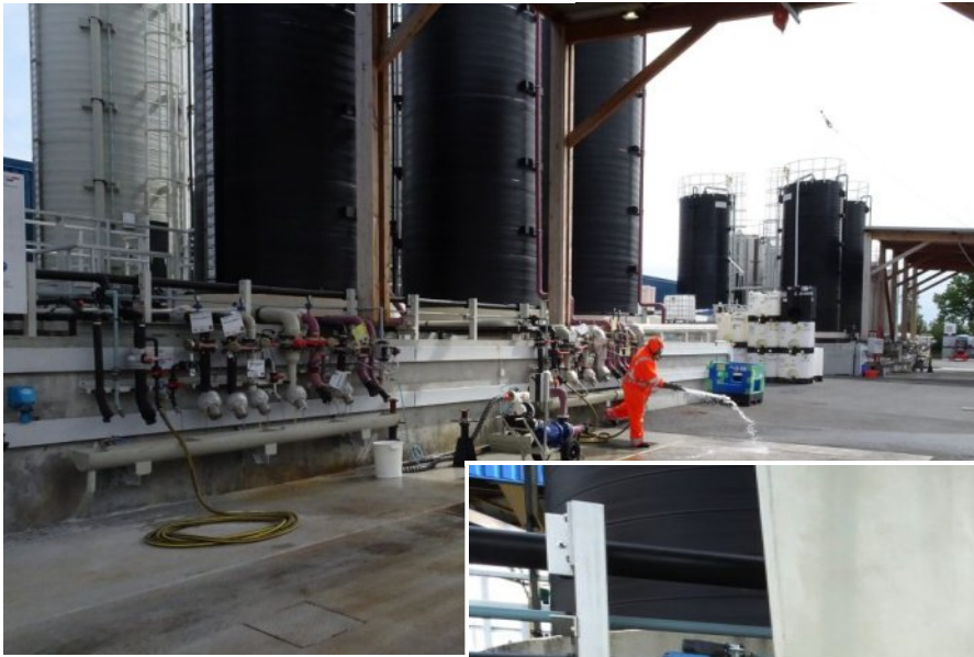
Vue 1 - Aire de dépotage des bases
