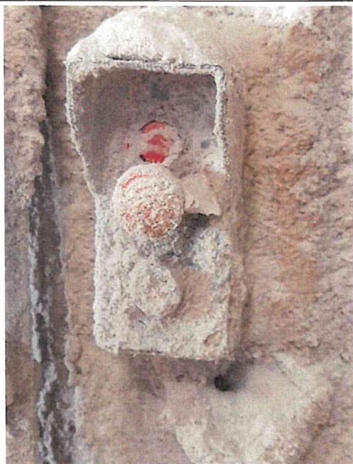
Photo n° 11 Amas de poussières sur équipement de sécurité
