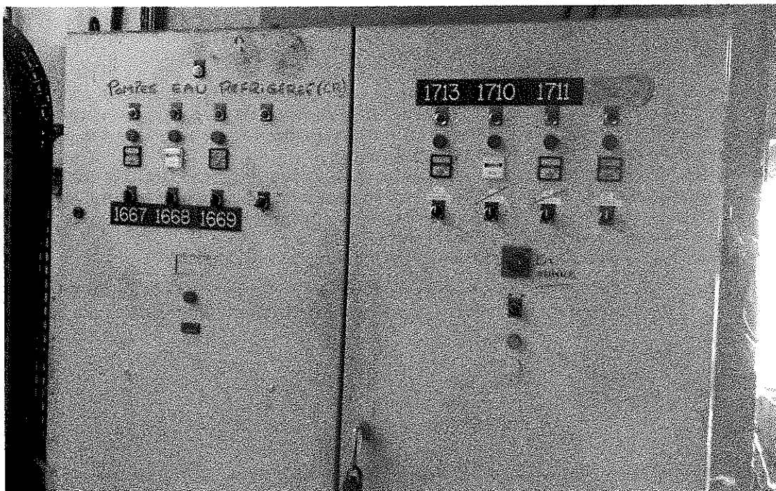
Figure 2: Tableau électrique des pompes de circulation consigné à l'arrêt Réf : 20210628-RAP-63-0846-INS_MFPM_Cataroux_cessation TAR_B41
