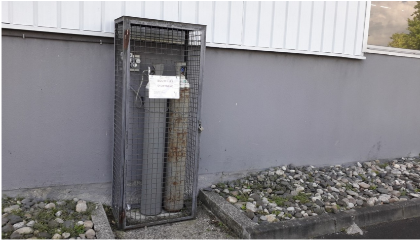
Figure 1: Stockage d'oxygène au nord du site, rue de Josserand : protection à ajouter pour éviter les chocs
