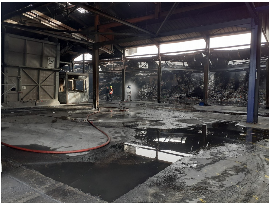
Photo 1 : vue intérieur du bâtiment sinistré (charpente métallique affaissée)
