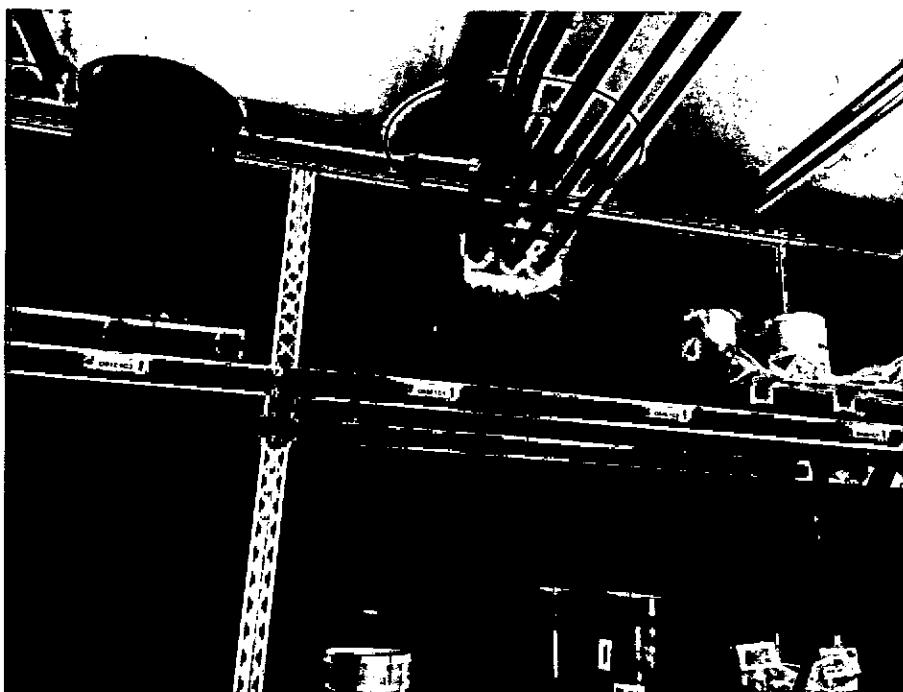
**Observation R16 :** Présence de traversées de tuyauteries et de câbles au droit des murs coupe-feu du local de stockage de produits liquides dangereux situé au sein de la partie production du site non calfeutrées. Par ailleurs, les tuyauteries traversant le local en partie haute ne sont plus attachées en plusieurs endroits sur les supports de tuyauteries (colliers de serrage manquant ou dévissés) - cf. photo suivante.
