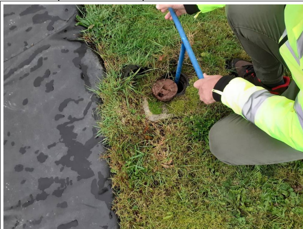
Manoeuvre de la vanne de sectionnement
