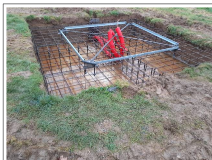
Fondations d'un des deux trackers solaires
