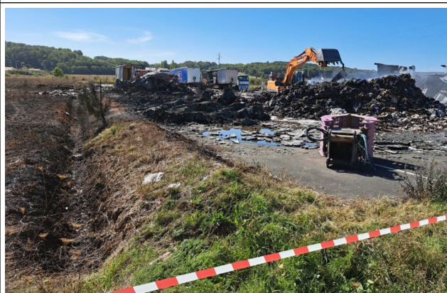
Pelle mécanique en action pour étaler les résidus de combustion afin de permettre leur refroidissement à cœur
