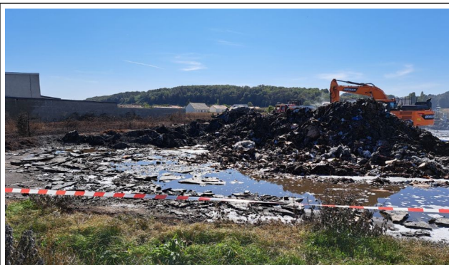
Pelle mécanique en action pour étaler les résidus de combustion afin de permettre leur refroidissement à cœur
