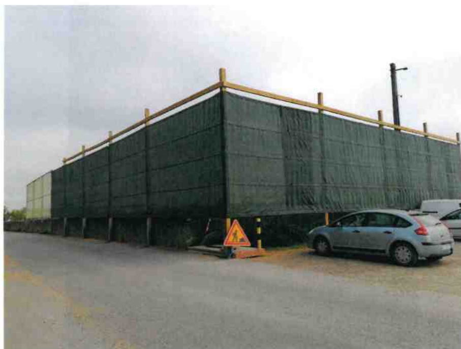
Mise en place d'un filet écran entre la SA BERNIER et le cimetière
