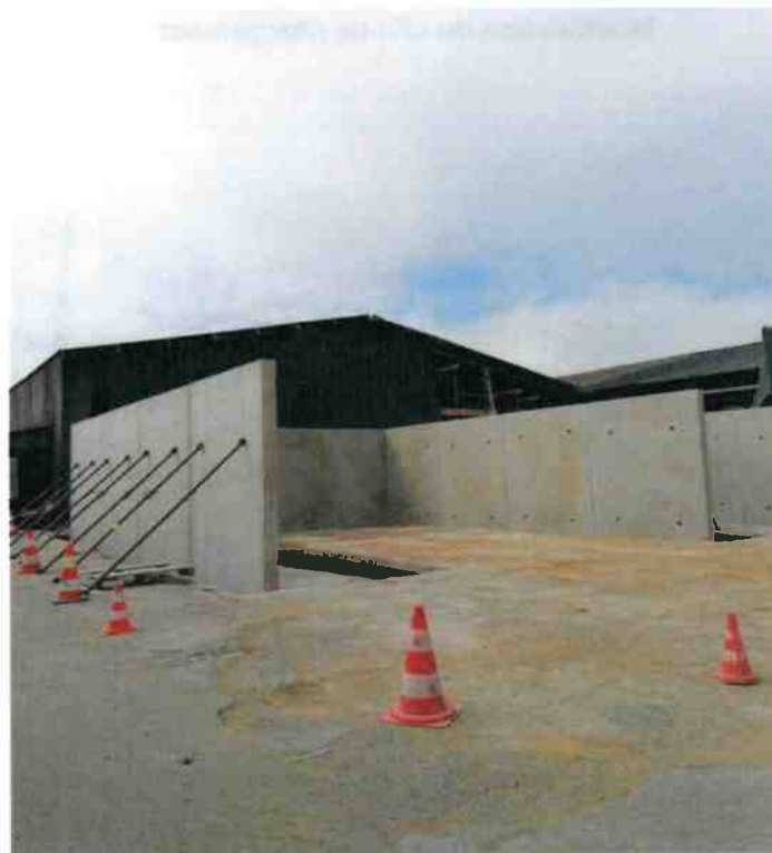
Travaux de reconstruction
