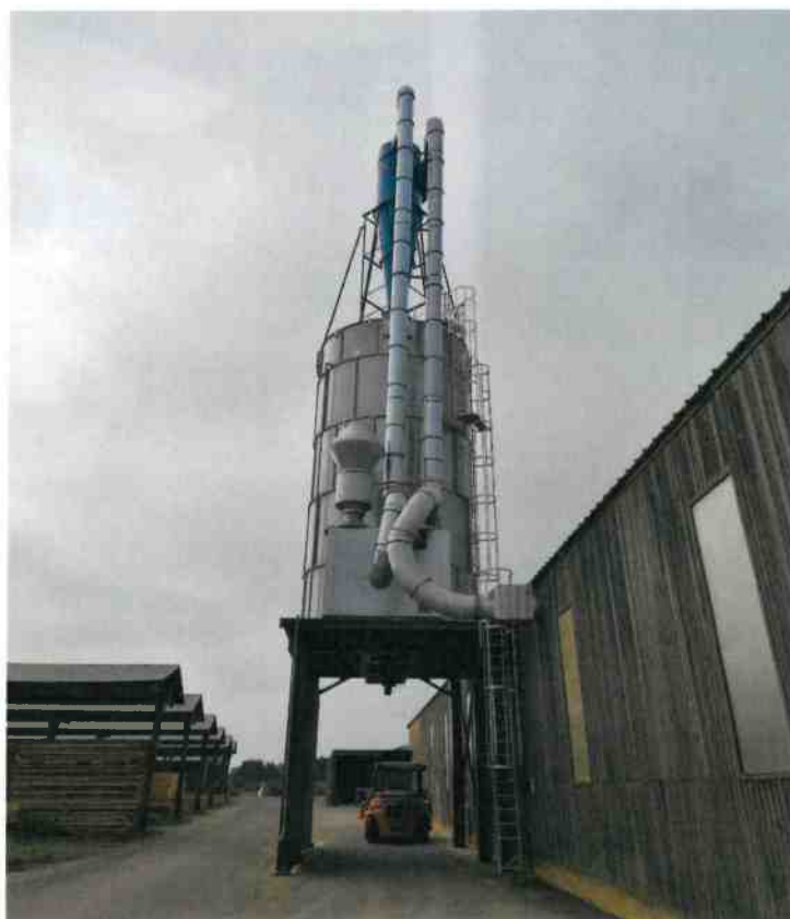
Modification du silo de chargement
