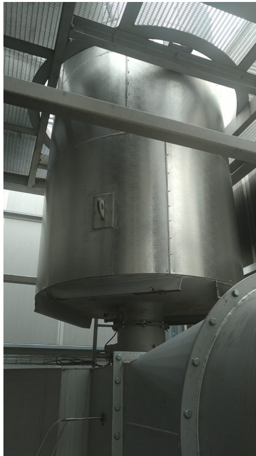
Échangeur thermique en sortie d'oxydateur
