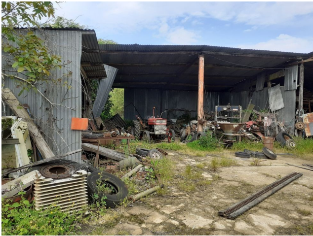
Repère n° 3 : hangar abritant des déchets métalliques ainsi que divers outillages
