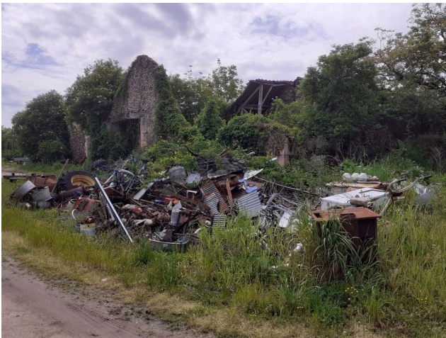
Repère n° 1 : stockage des déchets métalliques et de roues. Un congélateur est également visible.
