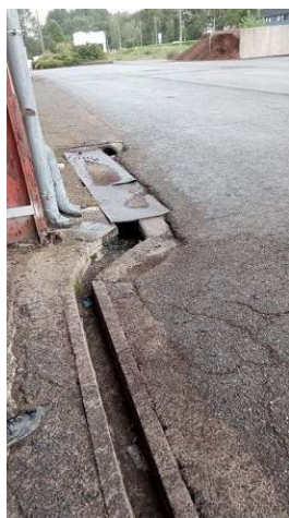
Évacuation des eaux de pluie côté Sud du bâtiment
