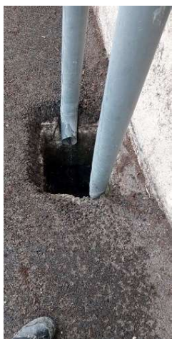
Descente des eaux de pluie de la toiture côté Sud
