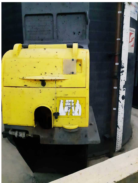
Nom du produit sur cuve de chlorure ferrique
