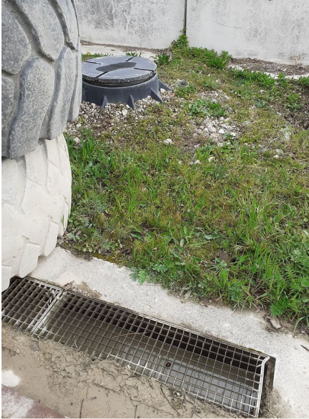
Séparateur d'hydrocarbures de la station de distribution
