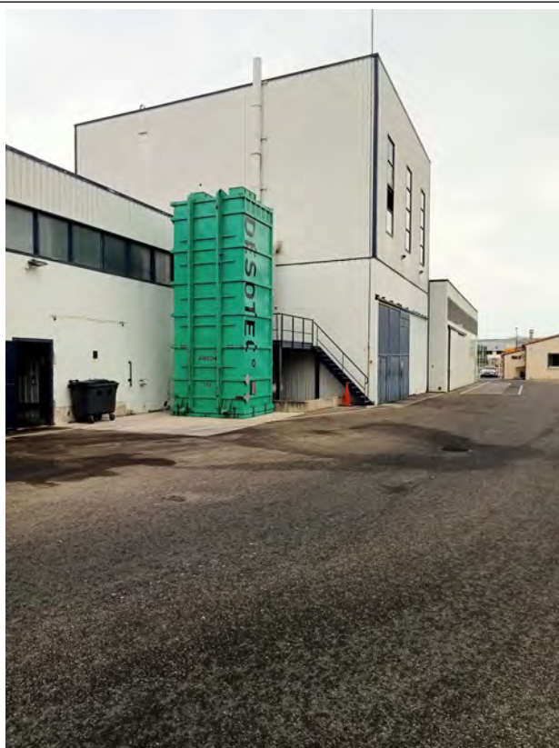
3 cuves "eaux séparées" sur rétention
